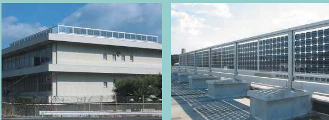
日立事業所内ビル屋上フェンス一体型太陽光発電実証試験
