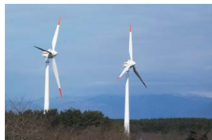
能代落合風力発電所「600kWの風力発電機2基」
