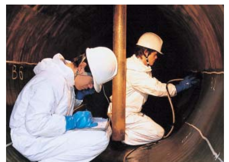
地下水タンクの腐食検査
