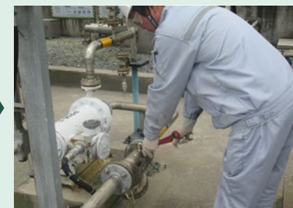
漏えい箇所の修理 (Repair)
