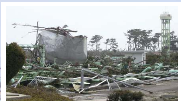
津波の衝撃で瓦礫と化した配管設備。汚水受入施設やポンプ棟、機械・電気設備など多くの施設・設備が破壊された
