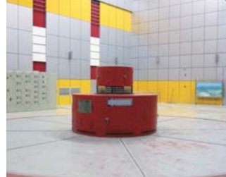
西龍池揚水発電所(中国)
