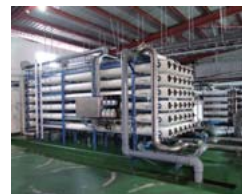
日立プラントテクノロジーの逆浸透膜法海水淡水化装置
