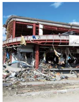
津波により建物全体が浸水し、外壁部やATMなどが流出した岩手県陸前高田市の北日本銀行高田支店
