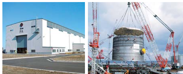
(左)モジュール工場(日立GEニュークリア・エナジー(株)日立事業所) (右)中国電力株式会社島根原子力発電所第3号機向け原子炉格納容器吊りこみ作業
