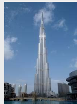
アラブ首長国連邦の 世界最高層ビル向け 空調設備一式を納入
