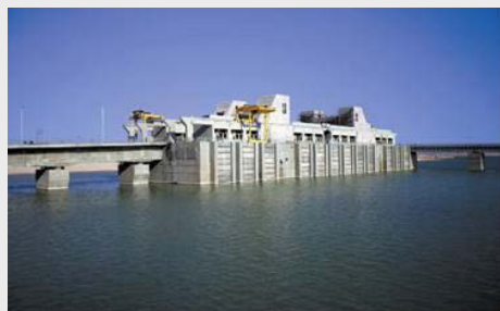
エジプト・アラブ共和国に 灌漑用大型送水ポンプを納入
